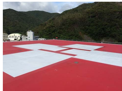
救命救急センター屋上のヘリポート
