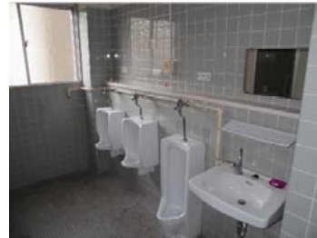
浴室・トイレ
