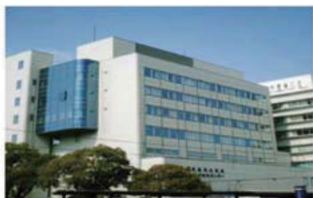
鹿児島市立病院 Kagoshima City Hospital
